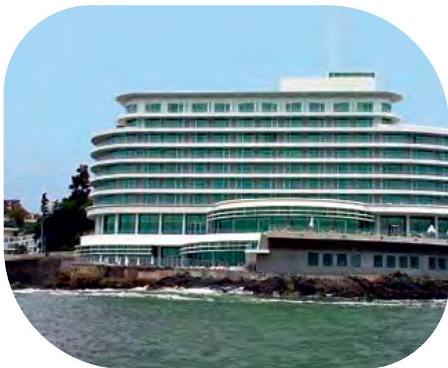
Pilkington EverGreen™ – Hotel Sheraton Miramar, Viña del Mar, Chile
