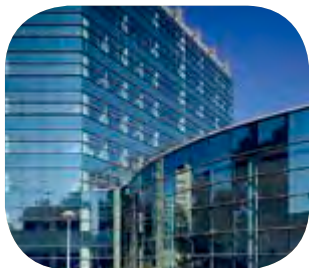
Pilkington Spandrel Glass Silikonowany – Politechnika Wrocławska, Wrocław
